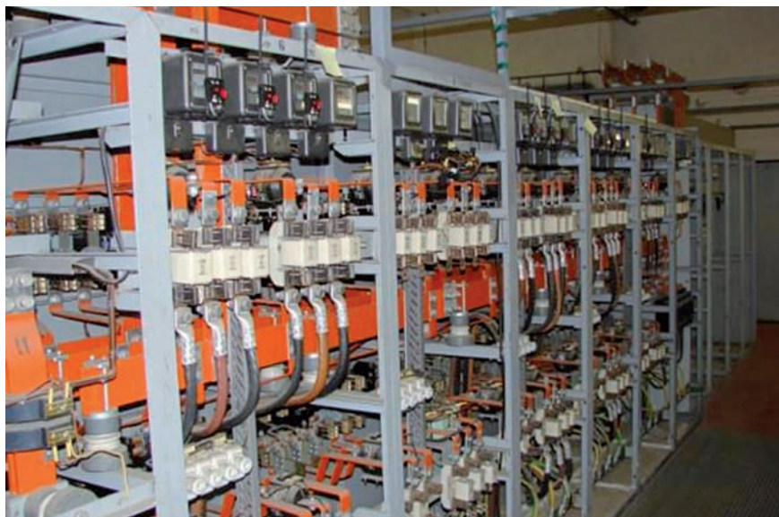
Obr. 7 Rozvádzač PENDA I (RH) nekrytý do vnútorných priestorov
