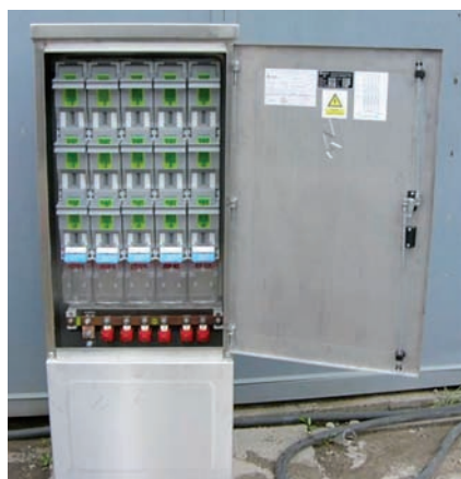
Obr. 6 Rozvádzač PENDA-O (RIS)
